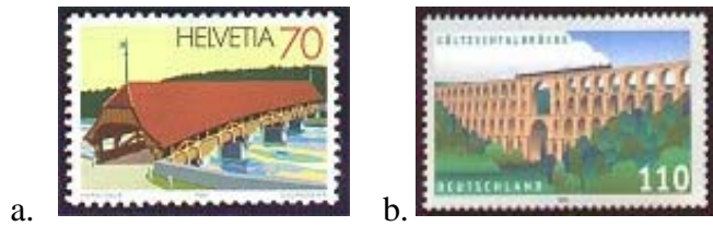
Figure 7 Wooden and masonry bridges. a. Neubrügg bridge. (Switzerland 1535) b. Göltschtalviadukt Mylay (Germany 1850)
